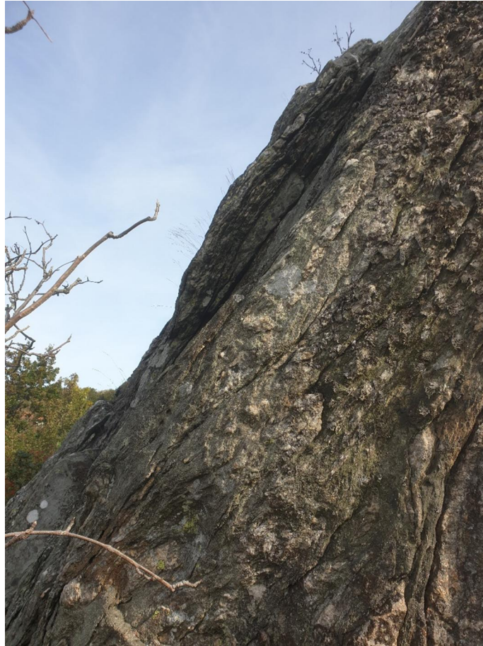
Figur 6 Skivigt berg i Område A, behöver följas upp i samband med sprängning, men anses som stabilt om ingen sprängning utförs i området.
